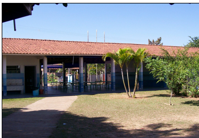
Fotografia 3 - Prédio “atual” (visão parcial), loco da pesquisa em maio/2009
