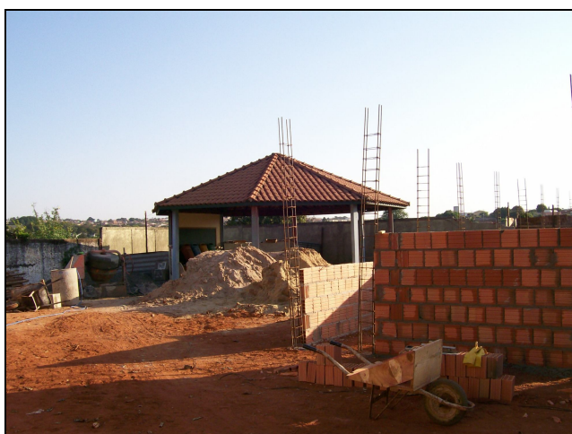
Fotografia 7 – Construção da EMEI “nova”
