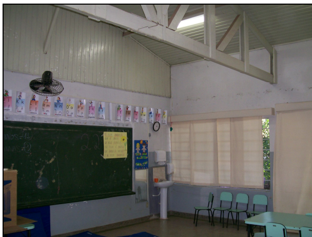
Fotografia 14 – Interior de uma sala de aula
