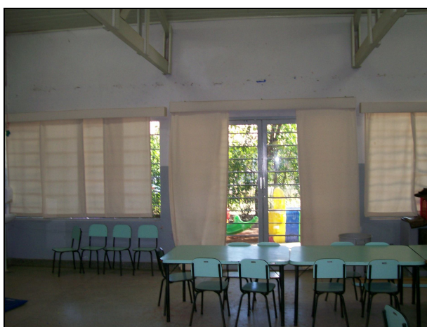
Fotografia 15 – Interior de uma sala de aula
