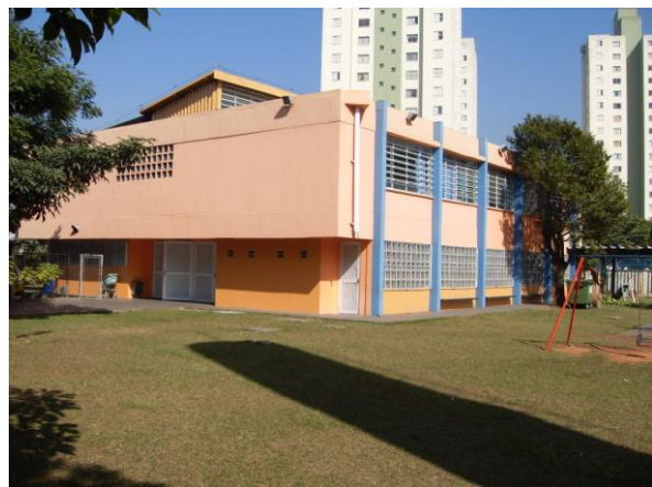
O prédio da escola visto do campo.
