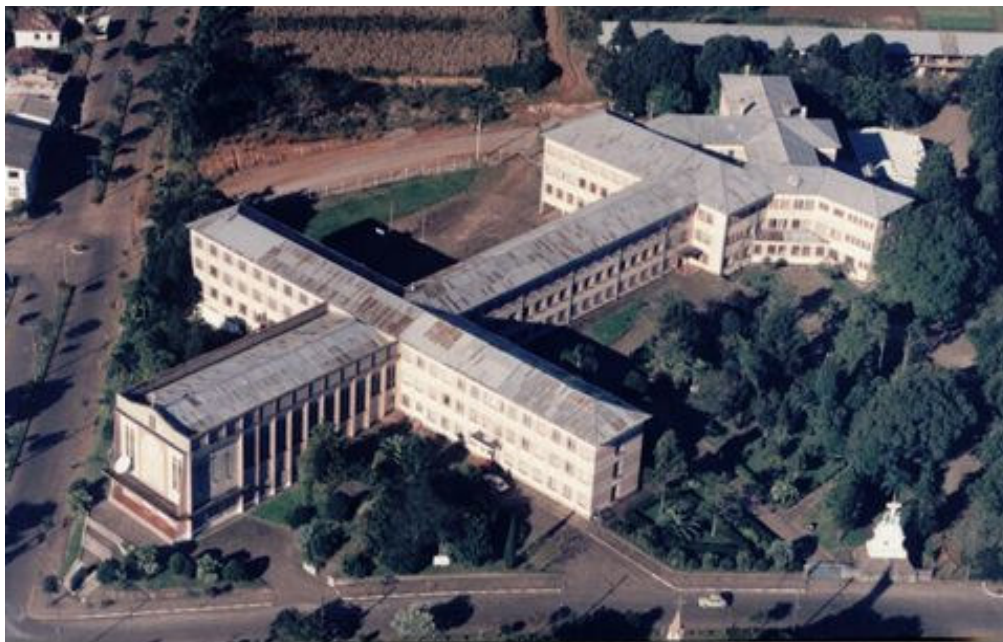
Vista aérea antiga do espaço físico quando a instituição quando esta se tratava do Seminário Seráfico São José.
