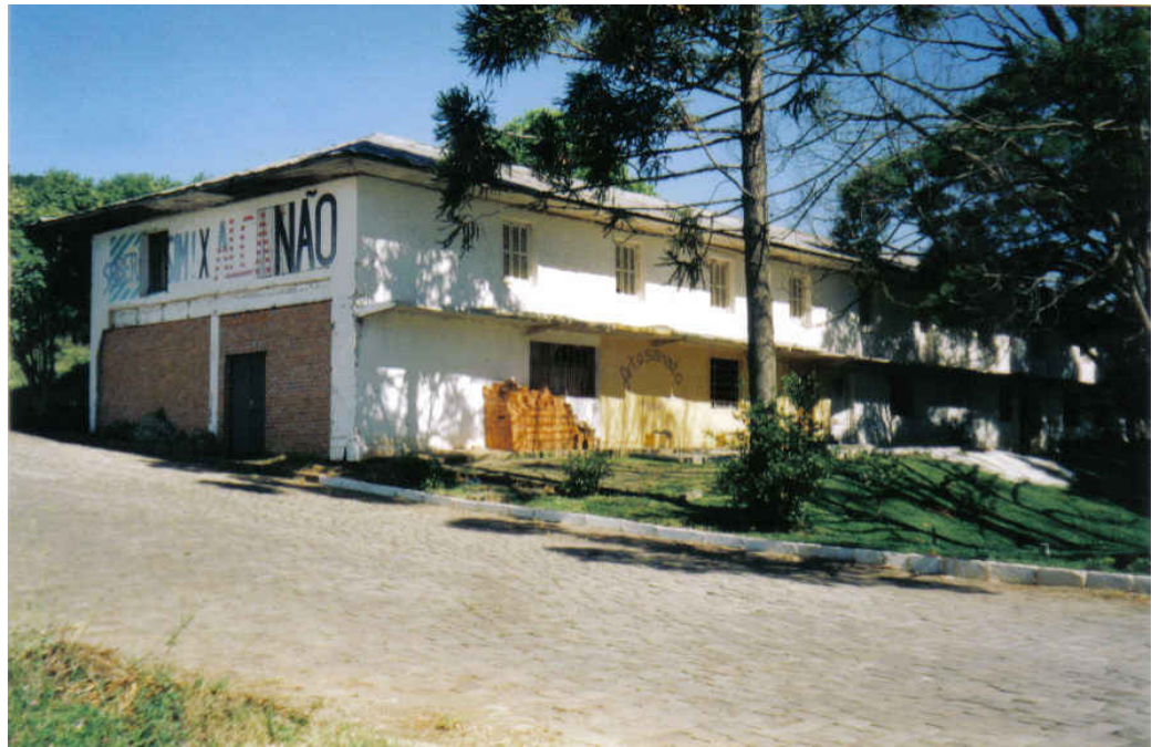
Vista externa do galpão que constitui a estrutura das dependências do Iterra.
