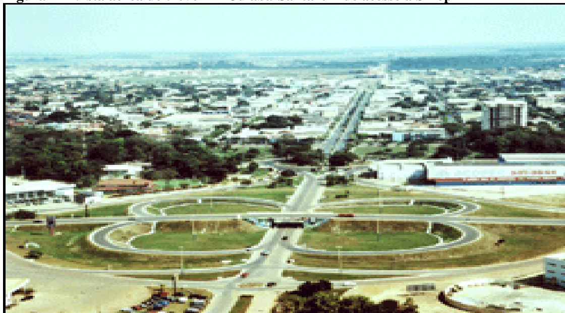
Figura 4 – Vista aérea do trevo BR Cuiabá-Santarém de acesso à Sinop 18
