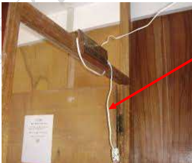
Foto: instalaciones permanentes con cable mellizo
