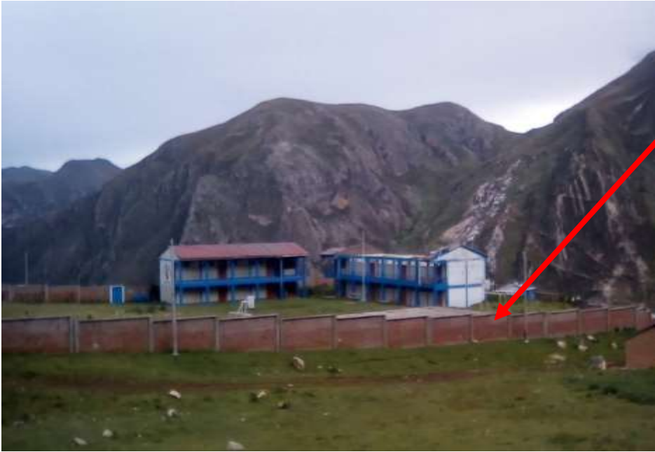
Foto: cerco perimétrico de ladrillo presenta daños por humedad
