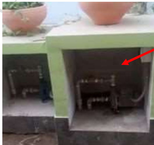
Foto: electrobomba de agua protegido en estructura de concreto
