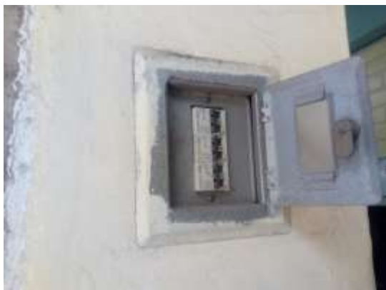
Foto: la pintura del tablero eléctrico (pintura dieléctrica) está deteriorada o descascarada
