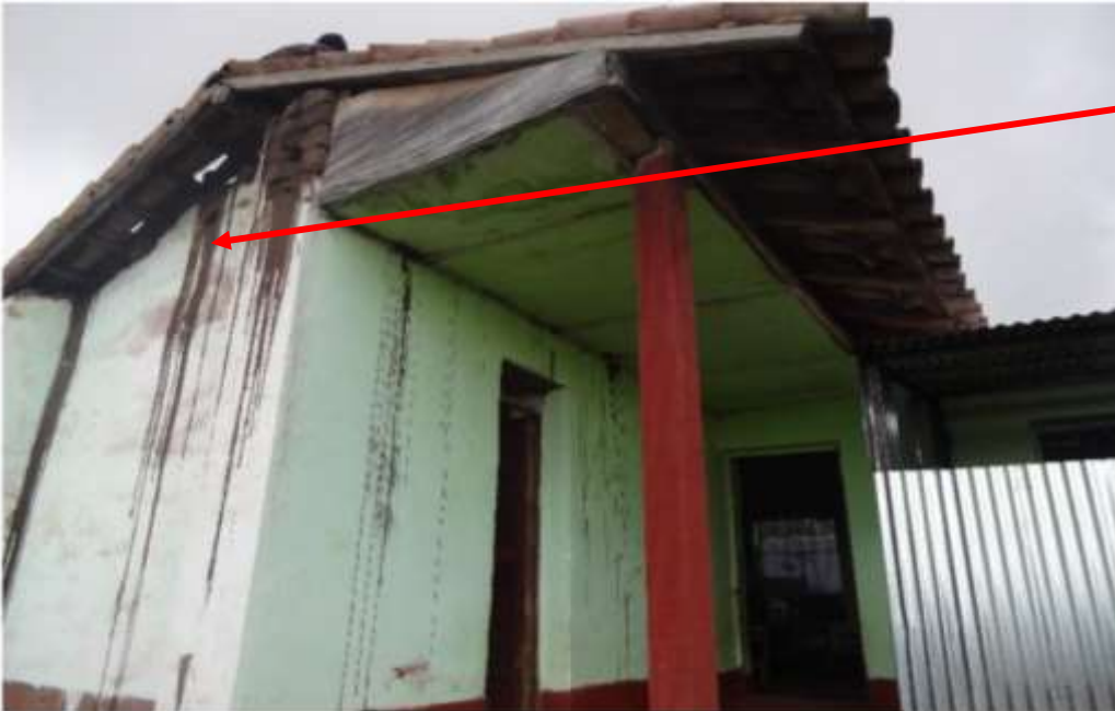
Foto: muro de adobe presenta daños por humedad
