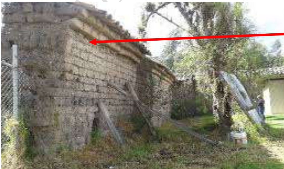
Foto: muro de adobe presenta daños por inclinaciones
