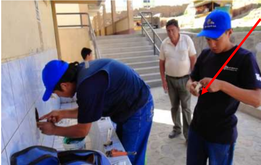
Foto: reparación de cañería por fuga de agua
