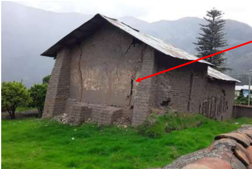
Foto: muro de adobe presenta daños por grietas
