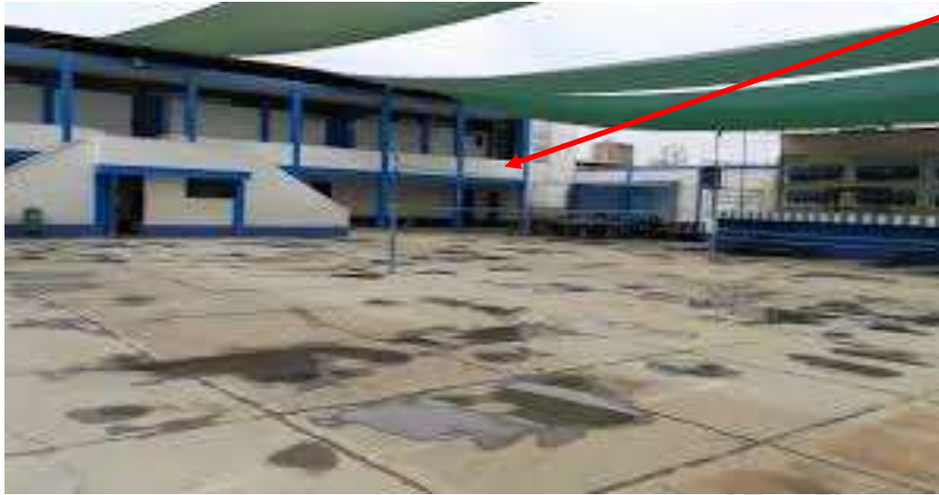
Foto: parapetos están confinados y amarrados por columnas
