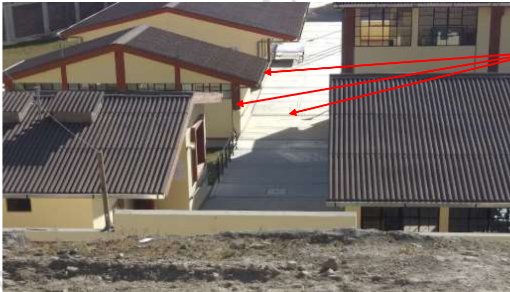
Foto: techo presenta cubierta inclinada y se compone de un sistema de evacuación de aguas pluviales (sumideros, canaletas y montantes pluviales, entre otros).
