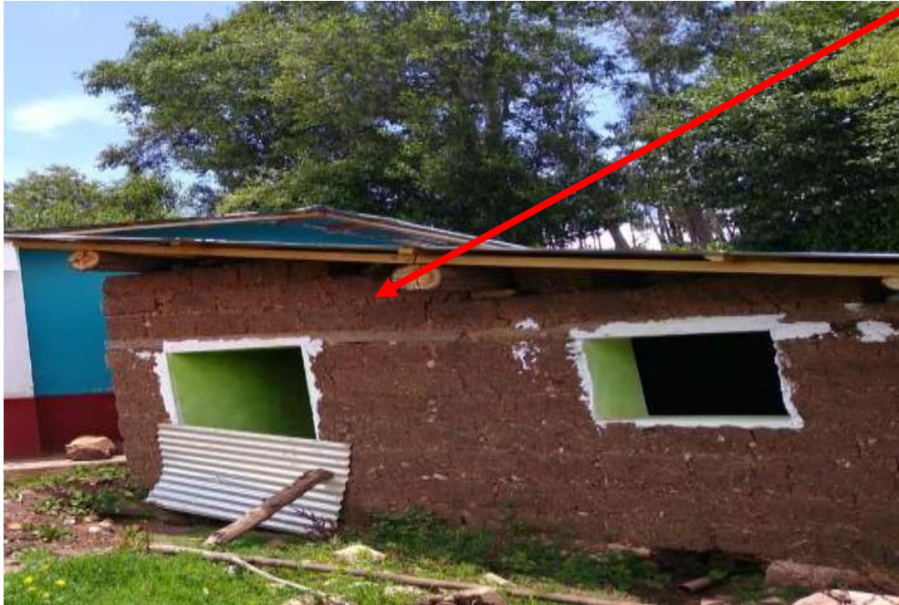
Foto: muro de adobe presenta daños por fisuras
