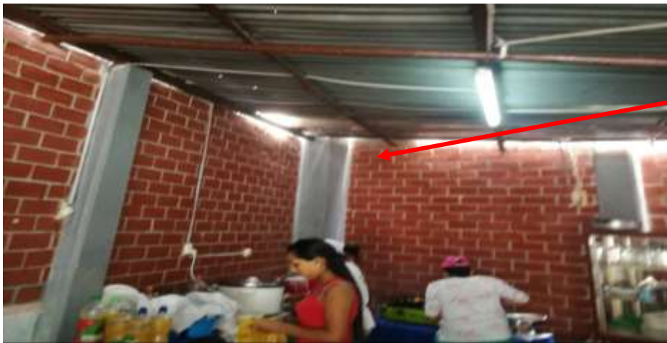
Foto: muro de ladrillo confinado
