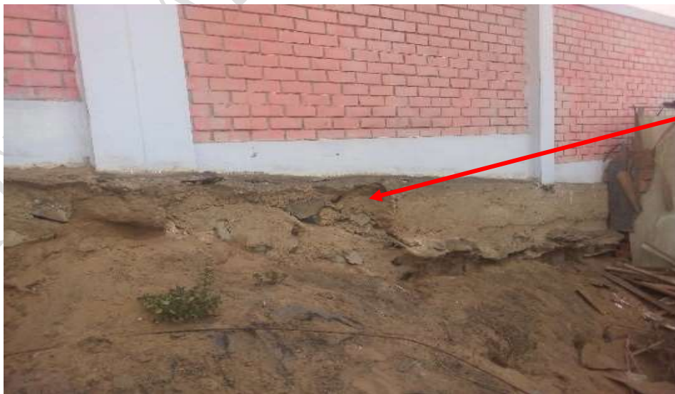
Foto: cimentación de cerco perimétrico se encuentra expuesto, en peligro de colapso
