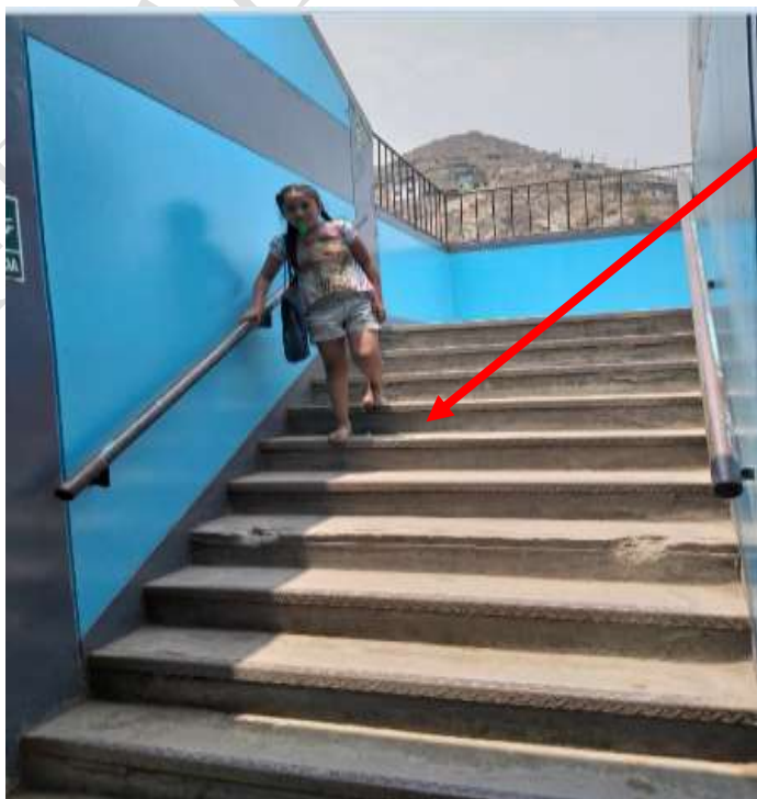
Foto: ancho de las escaleras 1.20 m
