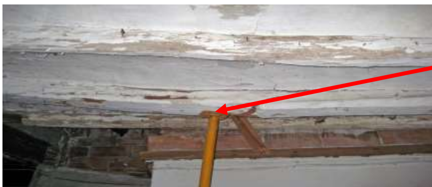
Foto: vigas de madera pandeadas
