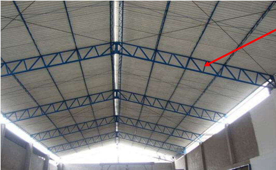
Foto: estructura de tijerales en buen estado
