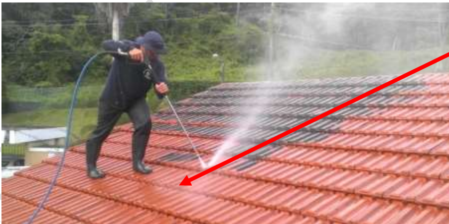
Foto: verificación del sistema de drenaje mediante surtimiento de agua con manguera
