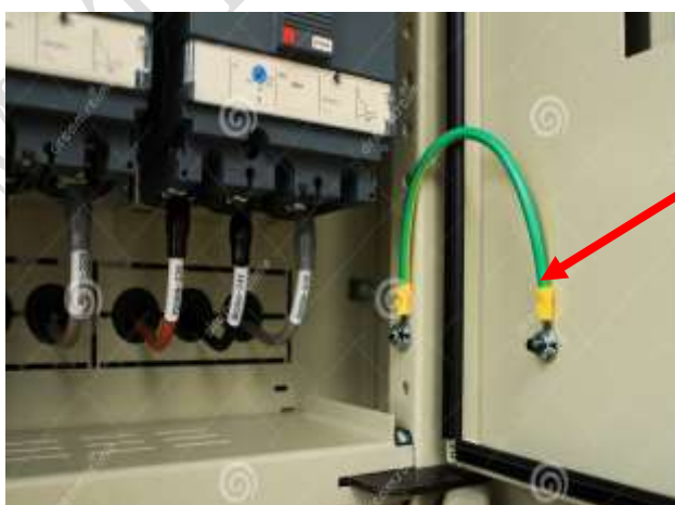
Foto: el tablero eléctrico con conexión a tierra
