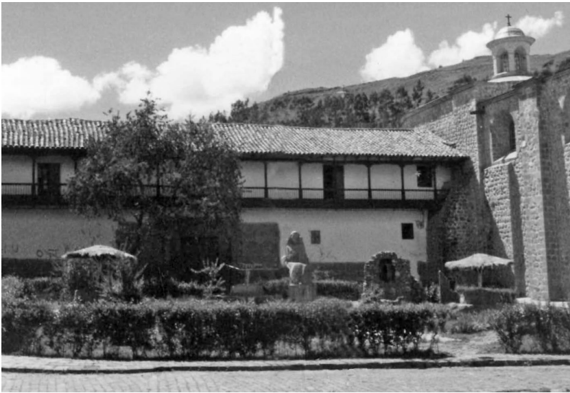
Ilustración 3. Foto de la casa de Diego de Silva, en el Cuzco. Archivo del autor.
