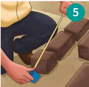
5 Las medidas de la cámara de combustión deben ser de 20 cm de ancho × 40 cm de profundidad × 20 cm de alto.
