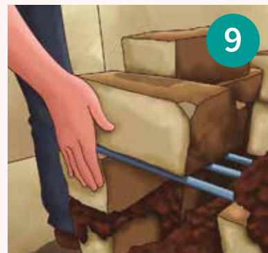
9 Colocar adobes encima de la varilla y completar el resto de la quinta capa de adobes.
