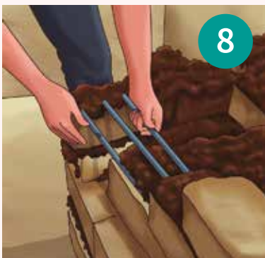
8 Colocar las varillas de 5/8 de pulgada de diámetro por 40 cm de largo.
