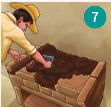
7 Rellenar y emparejar la tercera capa de adobes.
