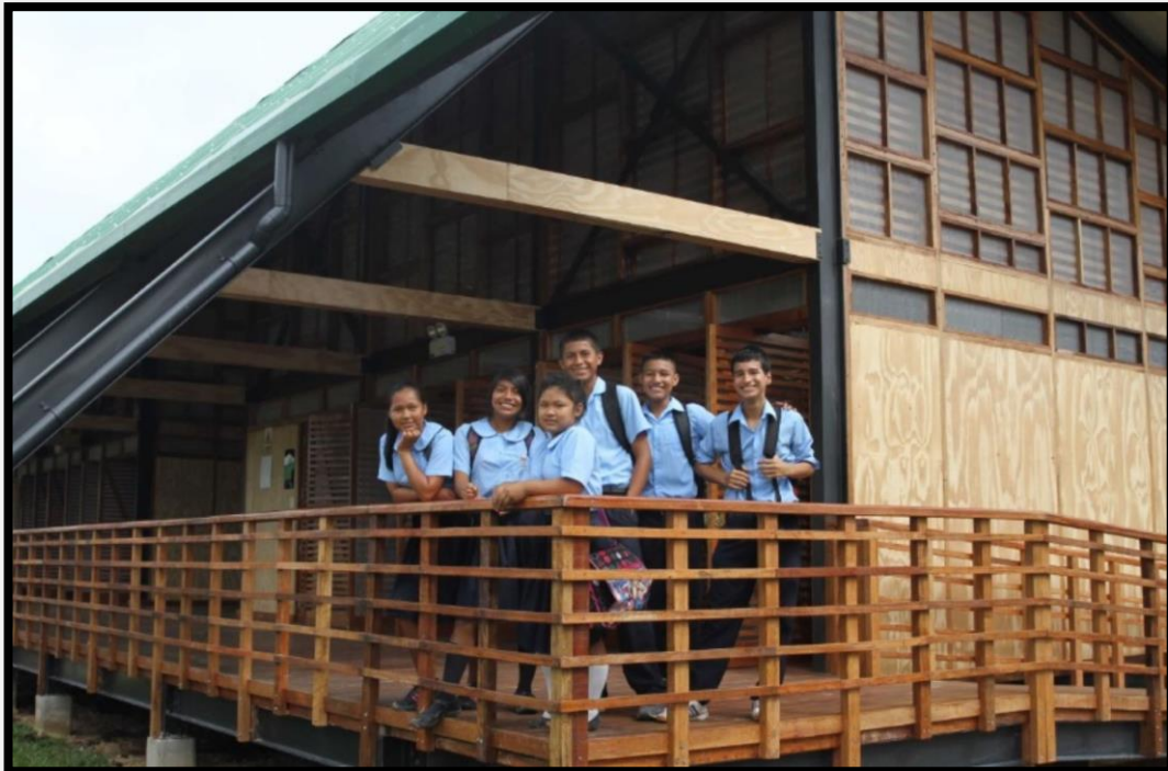
Cod 06: Madera estructural
