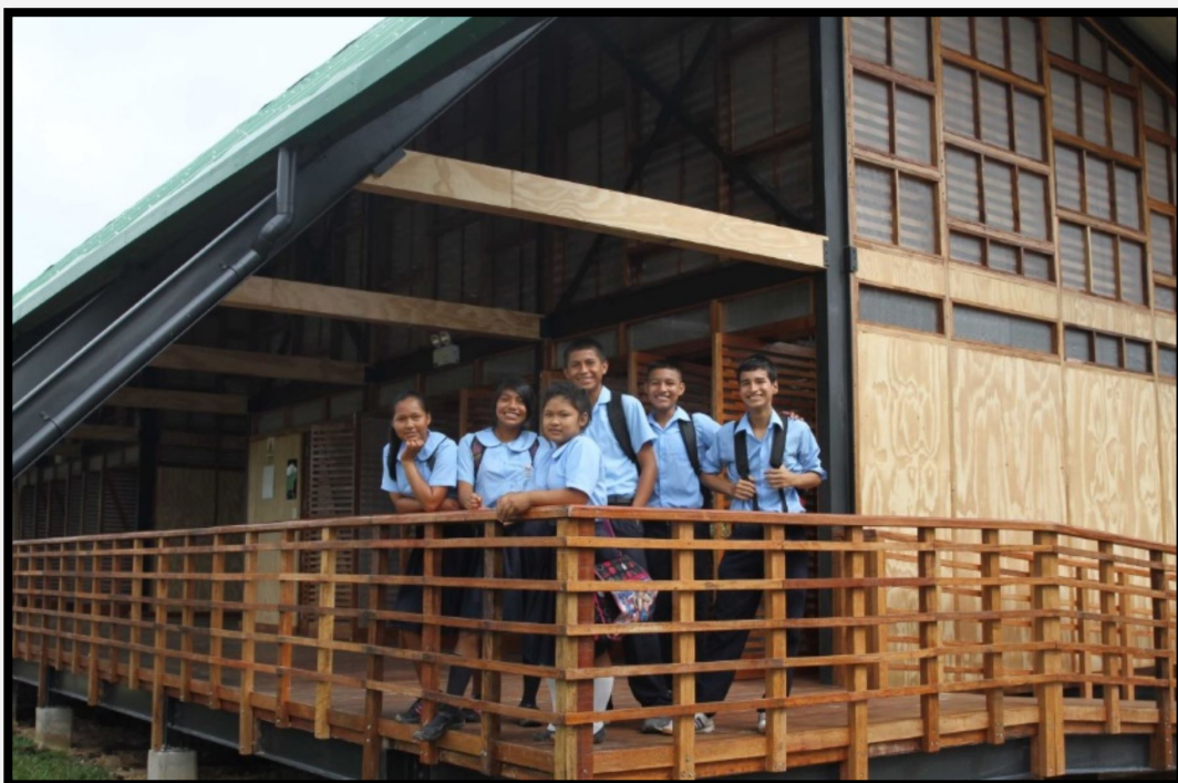
Cod 06: Madera estructural
