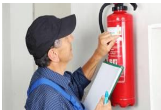
Imagen 6: Verificación de extintor
