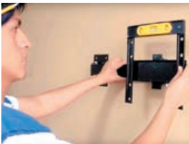
La colocación de un rack
