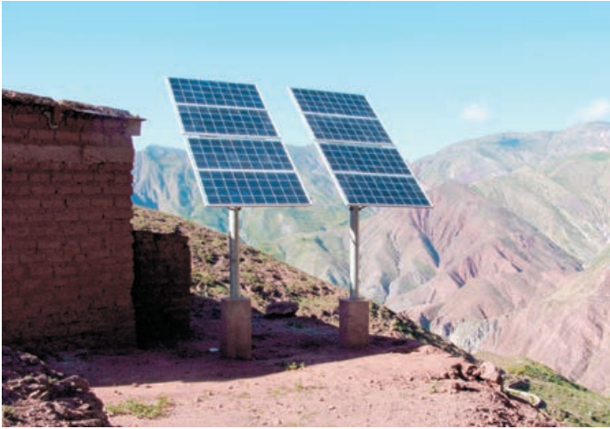
Paneles solares en la sierra del Perú
