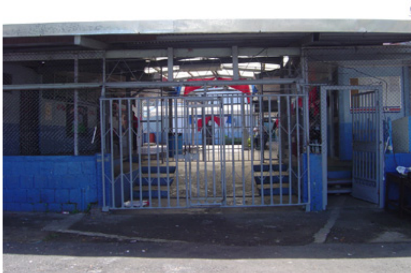
Figura 5.23. Entrada principal del CE-RD, costado Oeste
