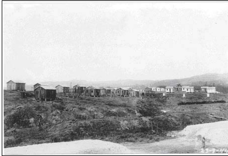
Figura 12: Início da construção da Vila Operária Fiorita (casas Tipo 1) – Siderópolis/SC (1944)
