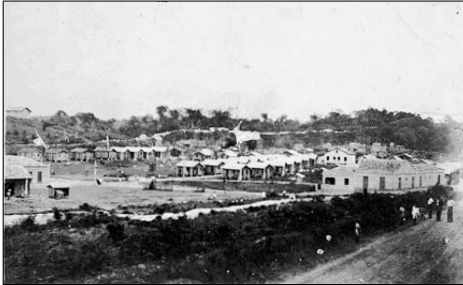
Figura 6: Vila Operária de Guatá – Lauro Muller/SC (1942) Fonte: Arquivo Pessoal de Dieter Dihlmann
