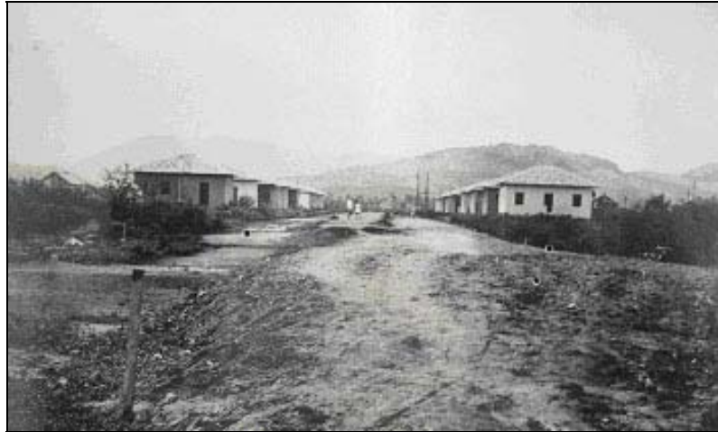
Figura 14: Início da construção da Vila Mendonça Lima, Tubarão/SC (1944) Fonte: Arquivo Público de Tubarão/SC
