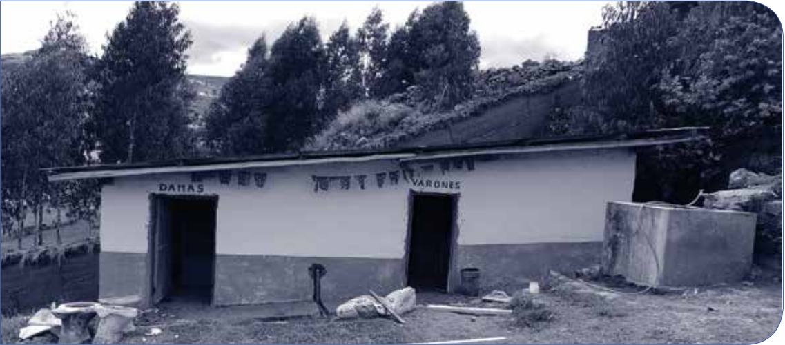
Fotografía 38. Servicios higiénicos de IE
