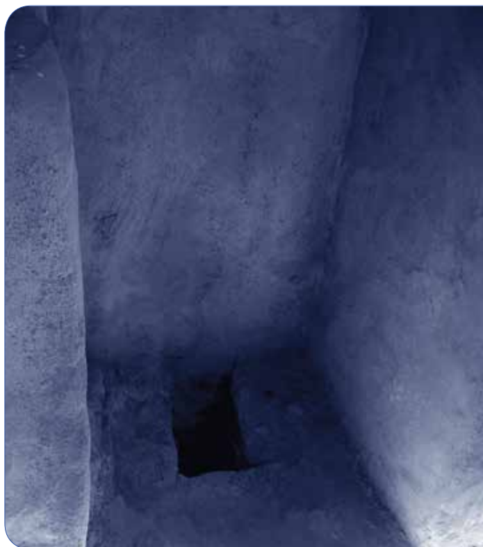
Fotografía 43. Silo de una IE
