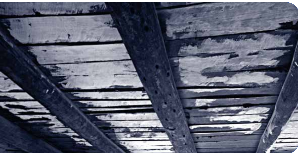
Fotografía 42. Techo de un aula
