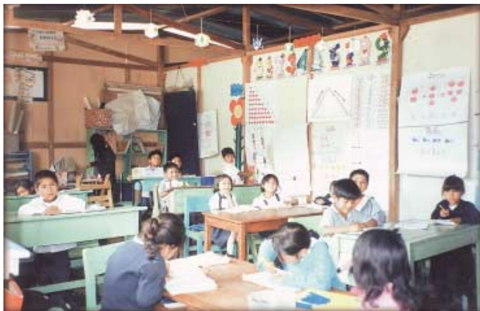
Aula construida con triplay en CEE de Ancash.
