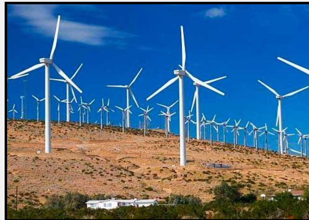
Cod 04: Energía eólica
