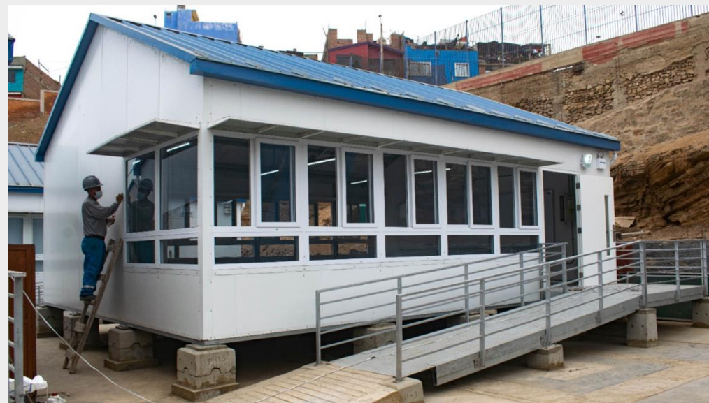
Módulo prefabricado Costa, PRONIED
